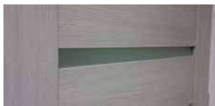
Стекланные вставки (матовые) между горизонтальными элементами полотна
