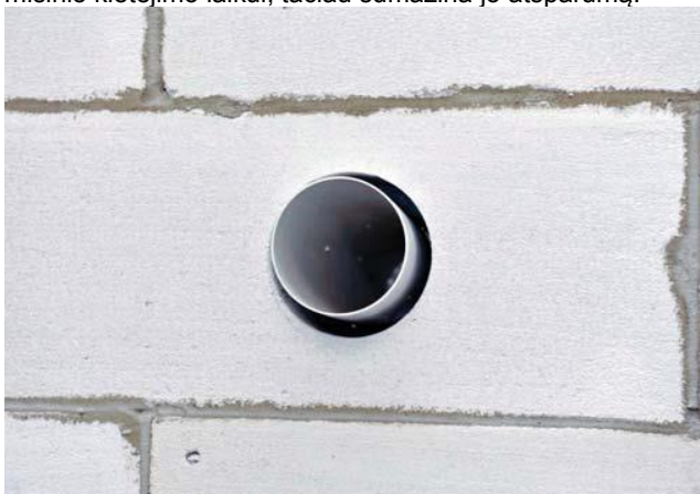
Įstatyti tvirtinama elementą į reikiama padėti
