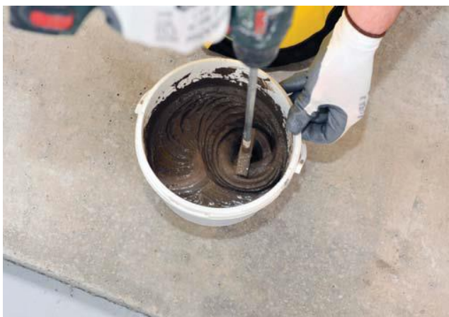
Maišyti, kol susidarys vienaalytė masė be grūdelių
