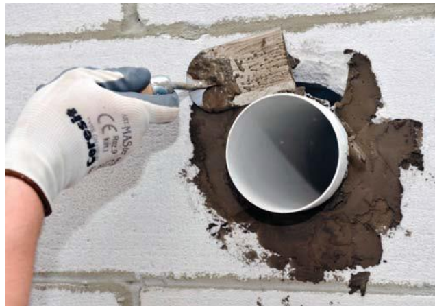
Aplink sutvirtinti mišiniu CX 5
