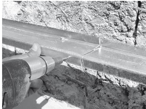
Z50 profilių jungimas; persidengimas 100 mm
